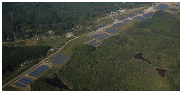
双葉渋川太陽光発電所全景
