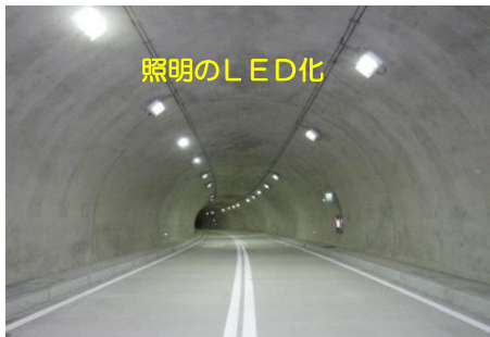
LED 事例 (国道 252 号 滝トンネル (金山町))
