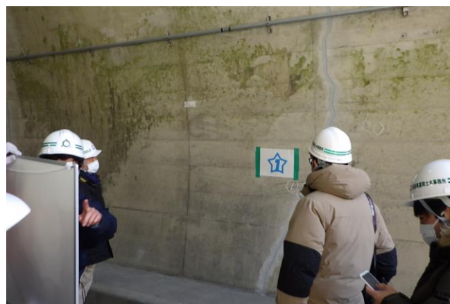
補修箇所の確認
