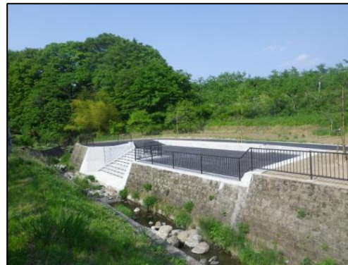
階段護岸工 (施工後)
