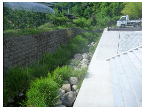
屋間の様子 (施工後の写真)
