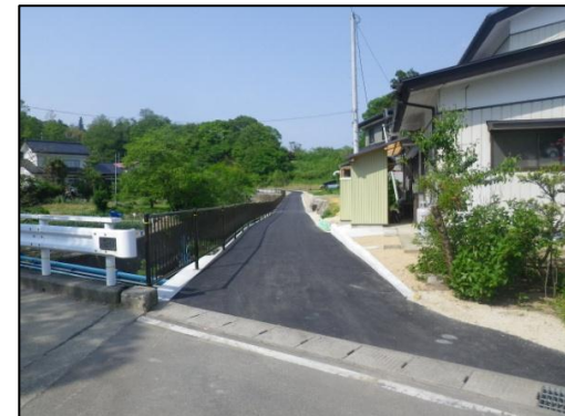
管理用通路 (施工後)
