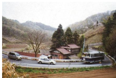
小綱木BP改良前の状況
