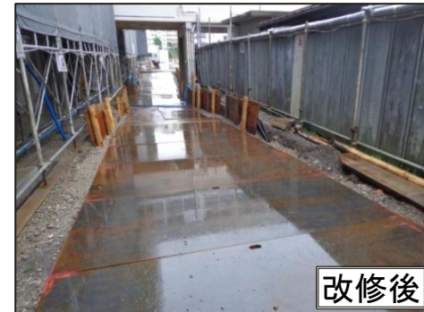
既設渡り廊下改修による『仮設通路(スロープ)』の確保状況
