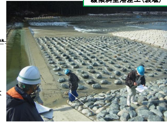
緩傾斜型落差工(袋堰)
