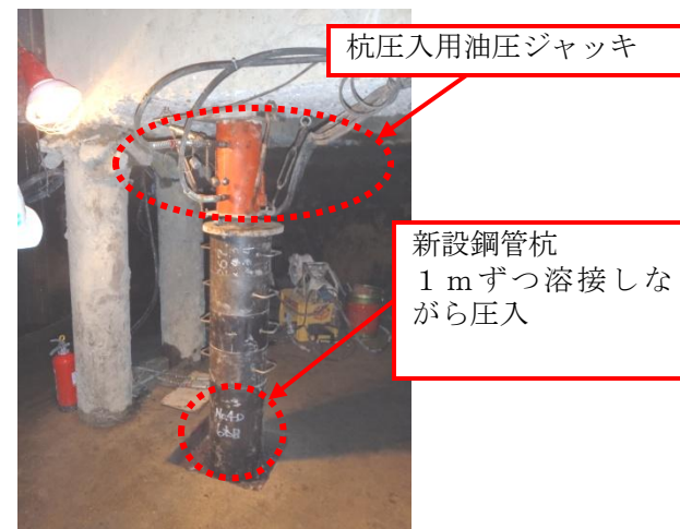
新設杭の圧入(16号棟)
