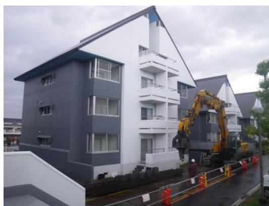
傾斜住棟(2号棟)
