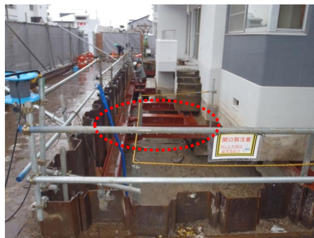
建物周囲の水平拘束材(余震対策)(2号棟)
