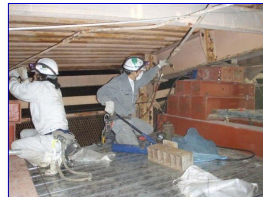
【フロテクター上部からのジャッキアップ状況】
