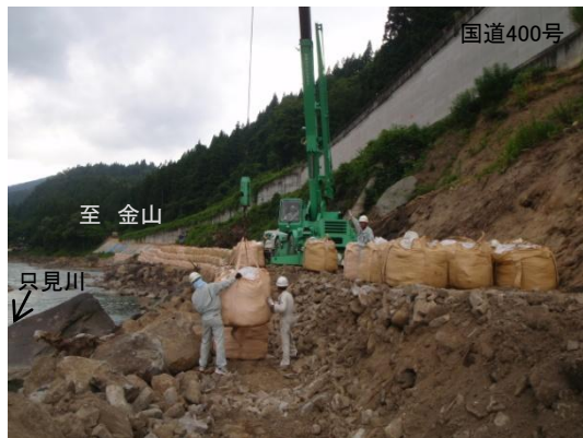
工事用仮設道路 施工状況
