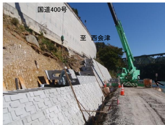
大型ブロック積み工 施工状況
