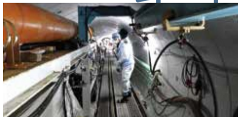
海底トンネル掘削工事の確認状況
