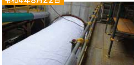
海底トンネル入り口付近の状況
