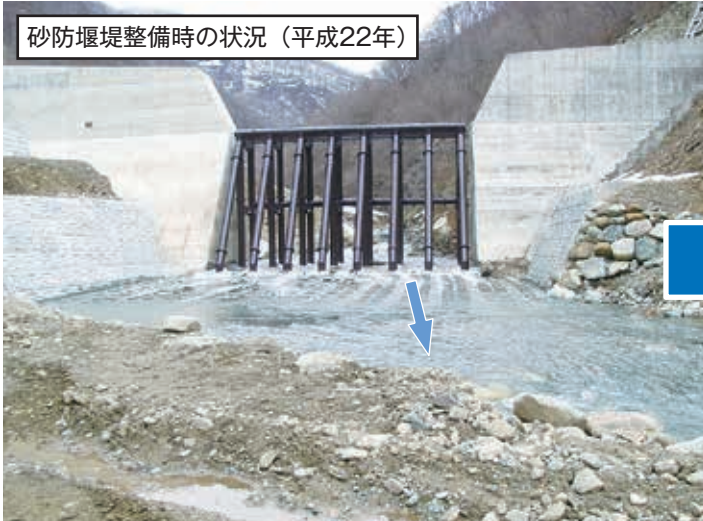
土砂が補足されている状況（令和元年5月）
