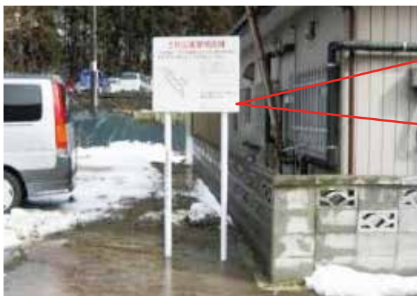
複柱式標識の設置イメージ
