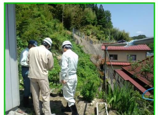
県、市町村職員による点検及び地域住民への注意喚起状況(急傾斜)
