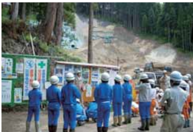
牛兵衛沢の工事現場見学
