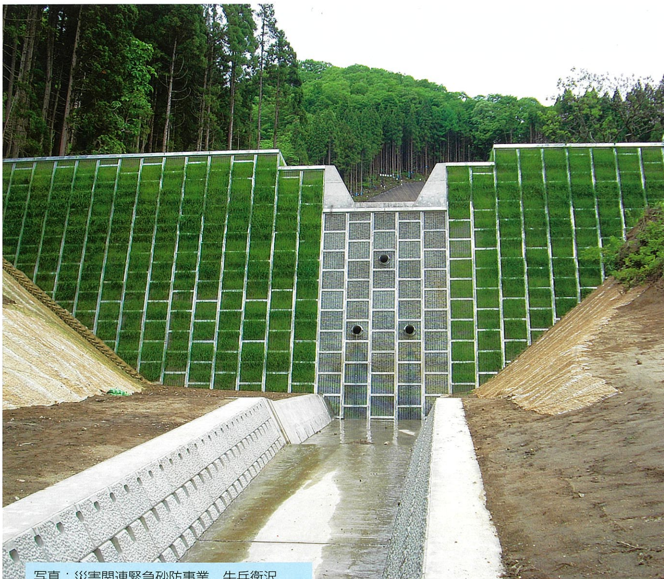
写真：災害関連緊急砂防事業 牛兵衛沢 大沼郡金山町大字小栗山字四十苅地内 (平成20年6月完了)
