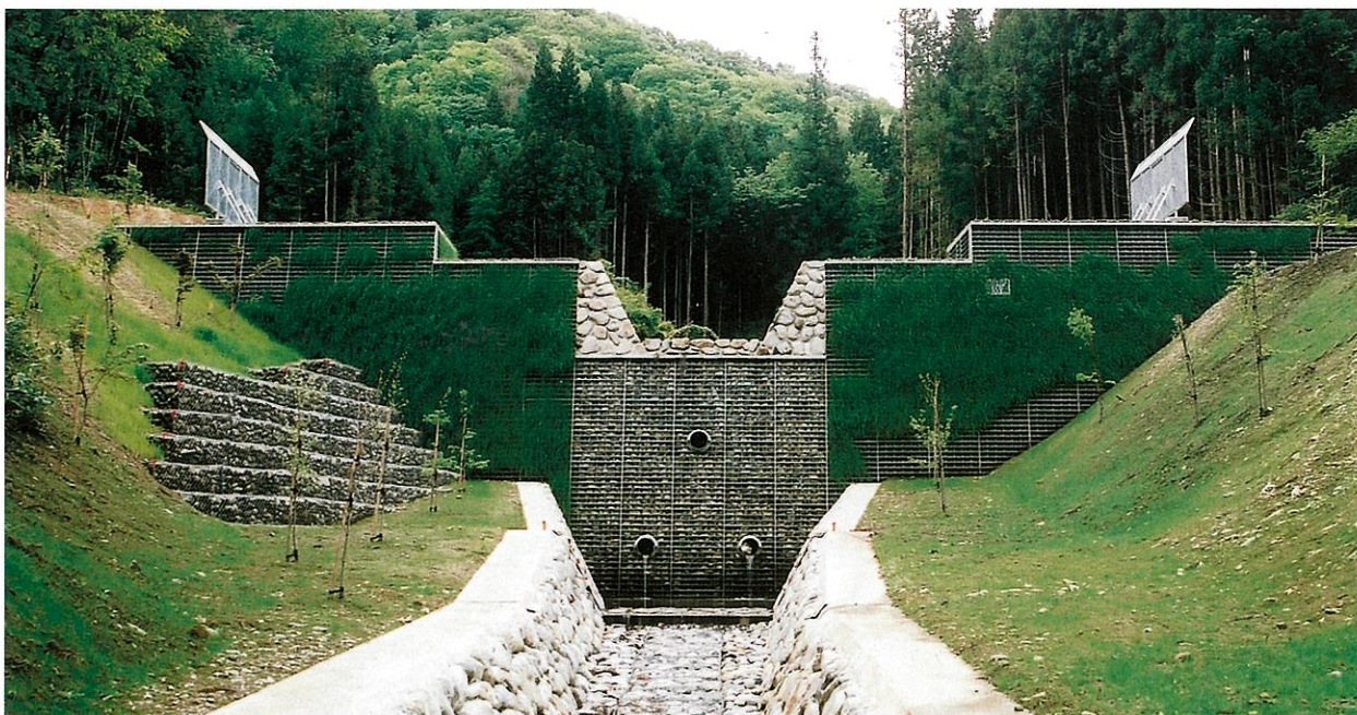
災害関連緊急砂防事業 フタ沢筋 南会津郡田島町大字田島字中町地内
