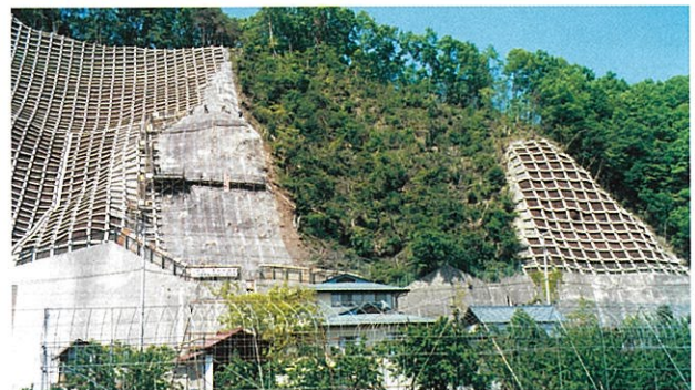
白岩地区 急傾斜地崩壊対策事業施工状況
