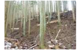
移動抑制対策(筋工)
