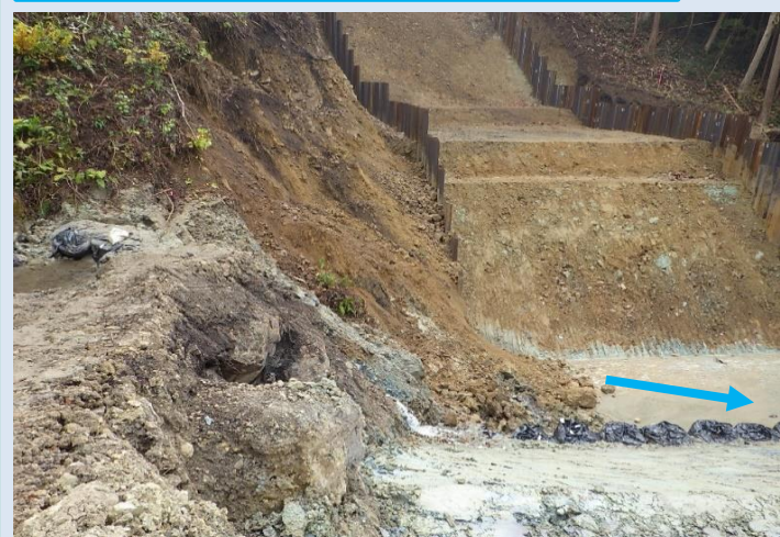
本堤基礎工施工状況(令和5年9月末時点)
