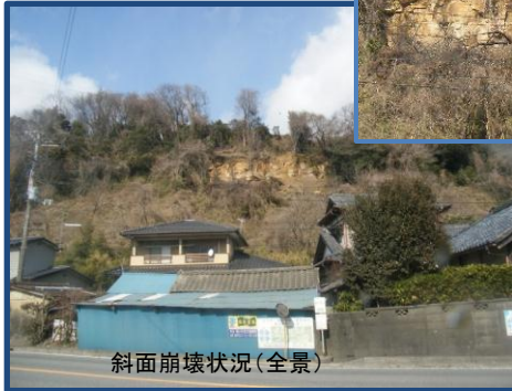
工事着手前 (斜面崩落状況)
