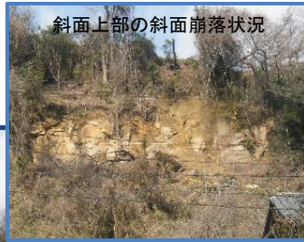
工事着手前 (斜面崩落状況)
