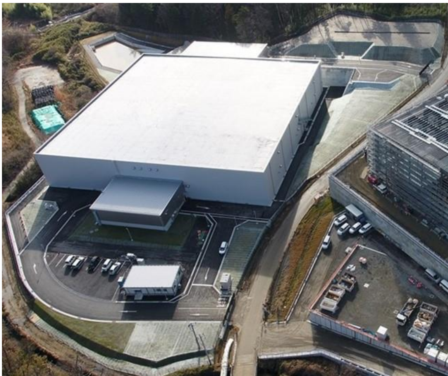
廃棄物貯蔵施設の外観
