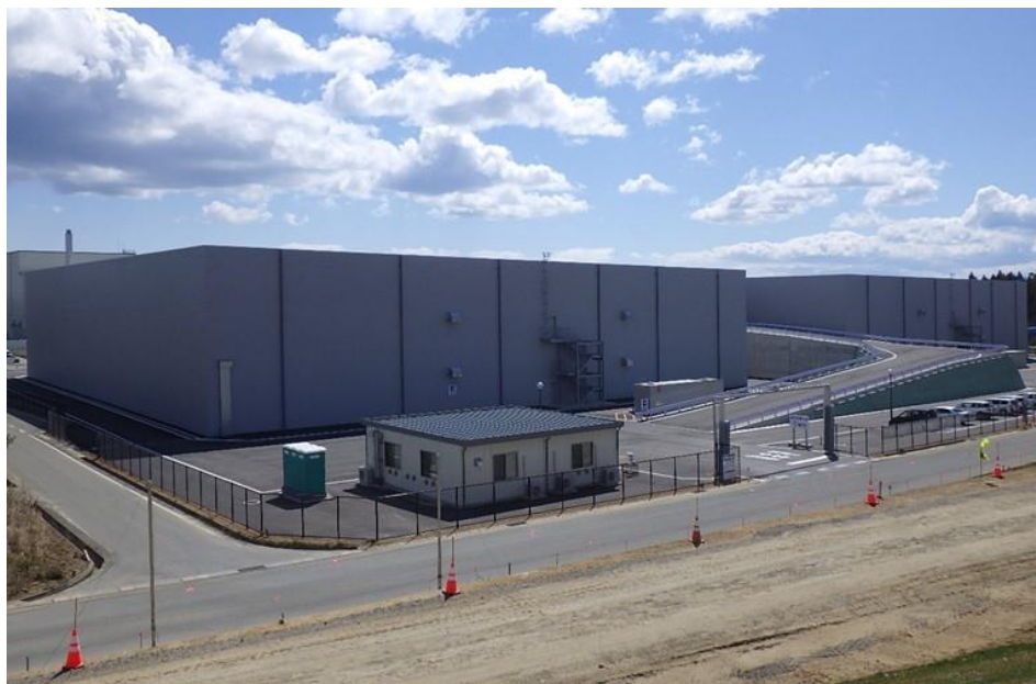
廃棄物貯蔵施設の外観
