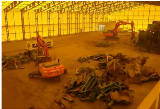
受入・分別施設(解体中)
