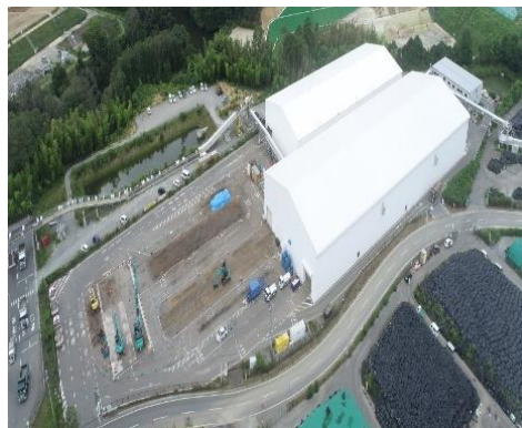
受入・分別施設(解体中)
