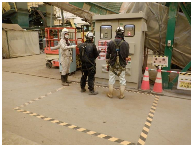
JV職員による退避確認
