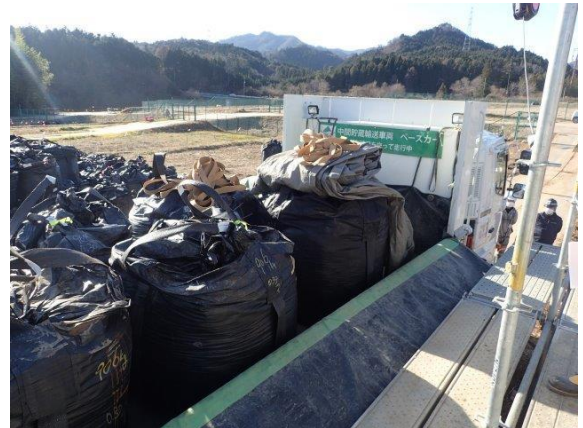
除去土壌等の積込作業
