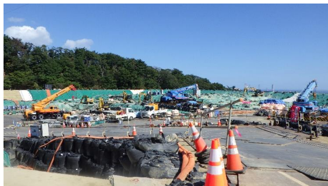
特定廃棄物埋立処分施設(上流側)
