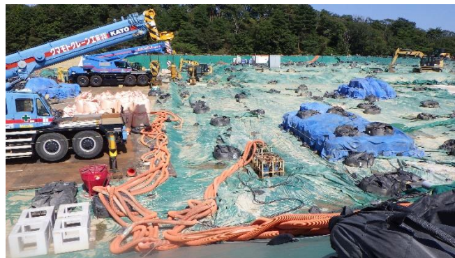
特定廃棄物埋立処分施設(下流側)
