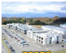
福島県環境創造センター
