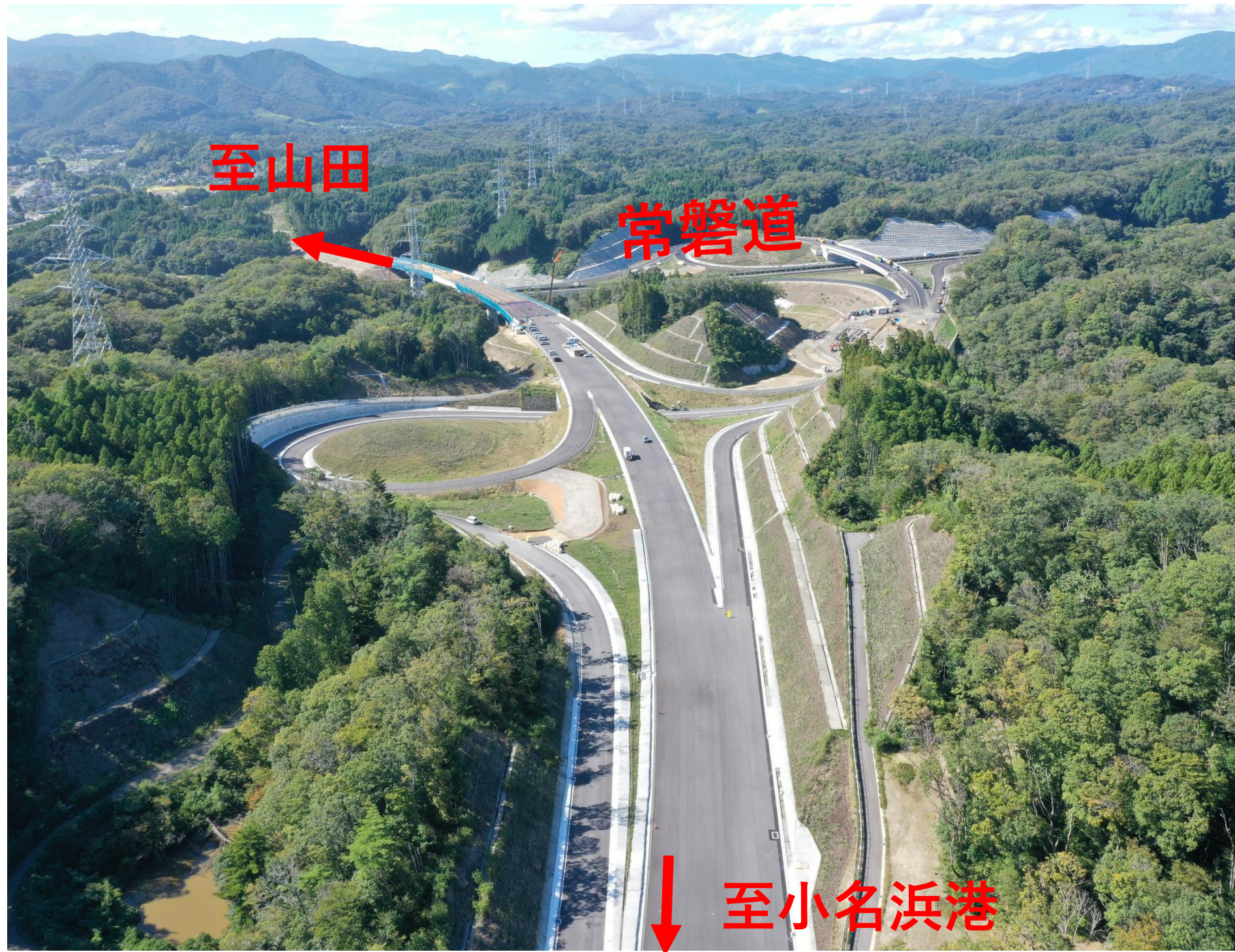
【写真⑨】 山田町地内（（仮称）いわき小名浜IC）
