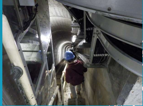
監査廊の見学
