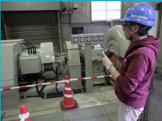
発電設備の見学
