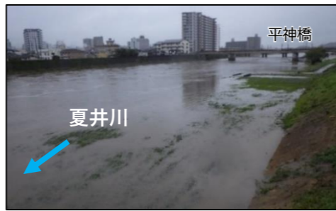
R5.9 夏井川出水状況 (いわき市平字下川原地内)
