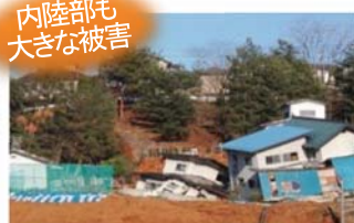
家屋被害の状況（福島市伏拝地区内）
