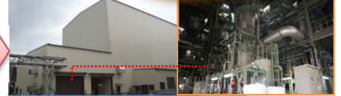
県中浄化センター内に焼却施設を導入
