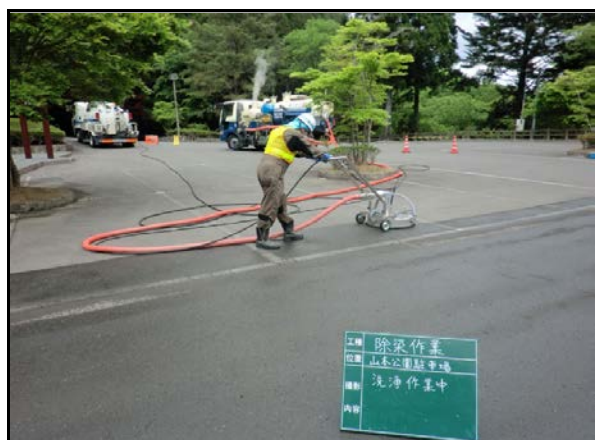
山本公園駐車場除染状況
