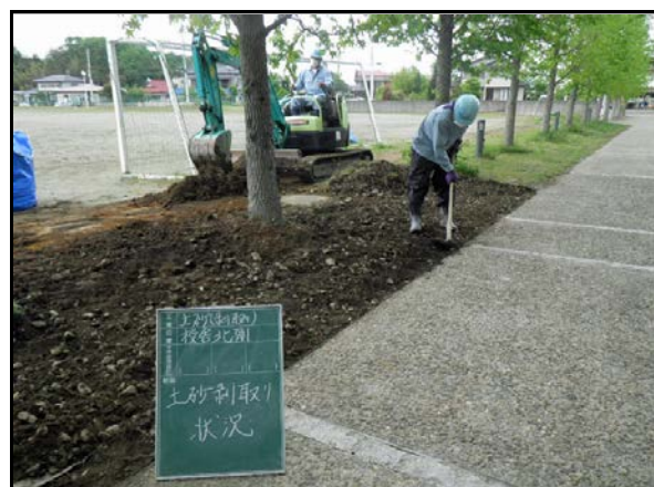
社川小学校除染状況
