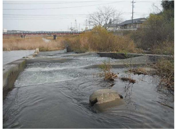
図8 曲田堰のハーフコーン型魚道
