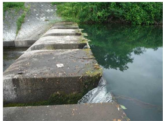
図24 堰堤の切り欠き
