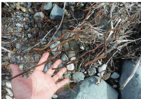
図31 南会津高校裏ジャカゴ堰の破損状況3
