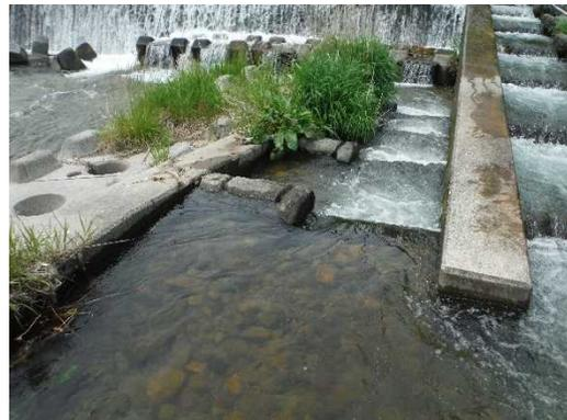
図8 堰の堆積と植物の繁茂状況
