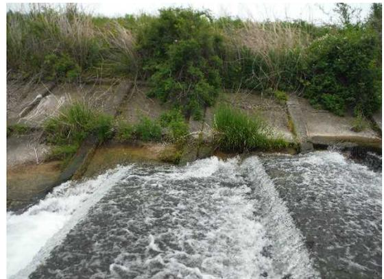
図13 帯工と法面の接地部分
