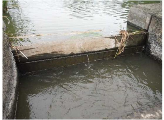
図22 角落としに設置された板
