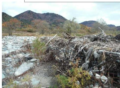
図30 南会津高校裏ジャカゴ堰の破損状況2
