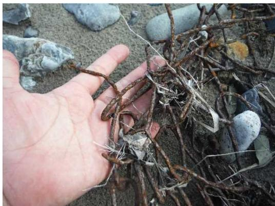
図35 処理場裏のジャカゴ堰の破損状況3
