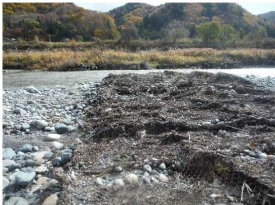
図33 処理場裏のジャカゴ堰の破損状況1
