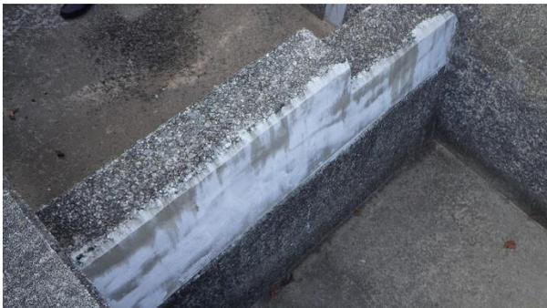
図8 補修された隔壁
