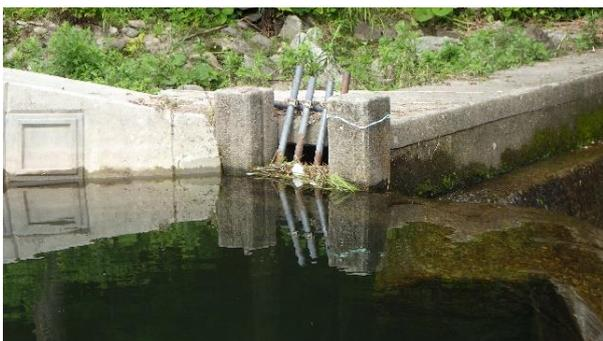
図23 山崎橋下流の堰堤の取水口
