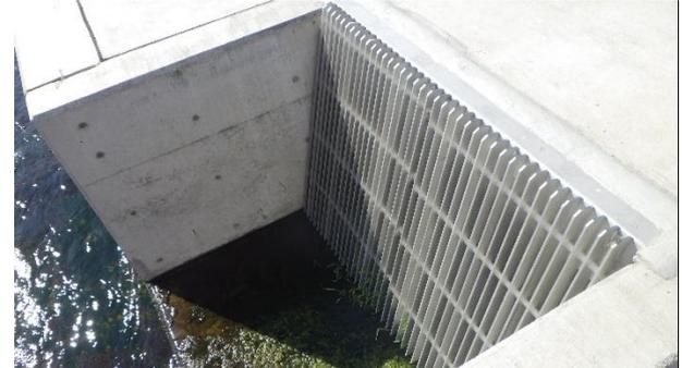
図7 魚道出口に隣接した取水口
