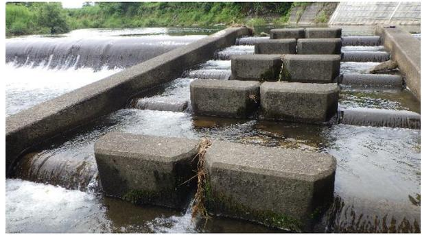
図20 山崎端下流の堰堤の魚道
