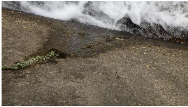
図25 魚道側面(右岸側)の亀裂
