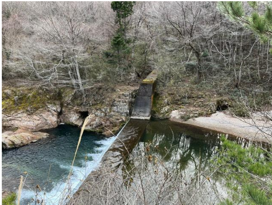
図1 入北沢砂防堰堤の魚道
